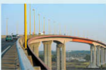
Ponts sur la Loire : pensez plutôt au ferroviaire
